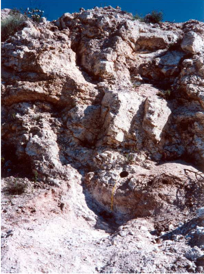
Figura 29.- Detalle del material que aparece, al abrir una calicata.
