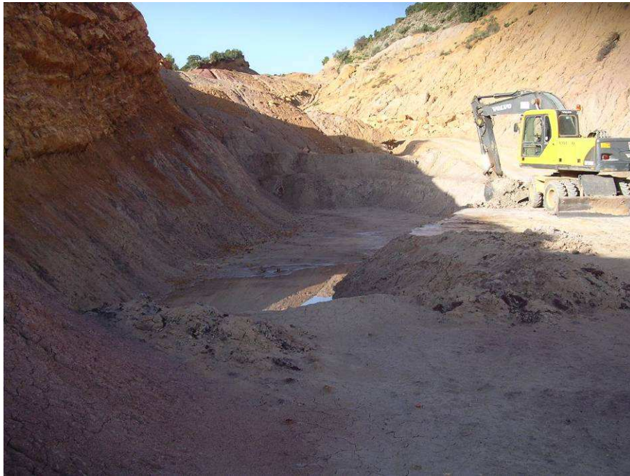
Figura 13.- Aspecto de uno de los frentes de extracción.
