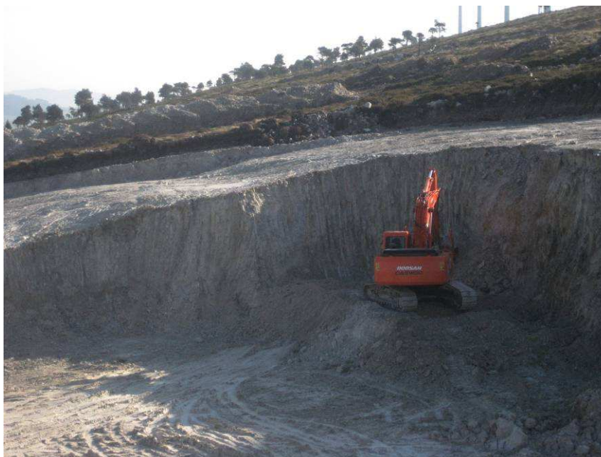
Figura 12.- Extracción del material mediante retroexcavadora (observese, en la parte superior de la fotografía, la presencia de los generadores eólicos que cubren la parte superior del relieve).
