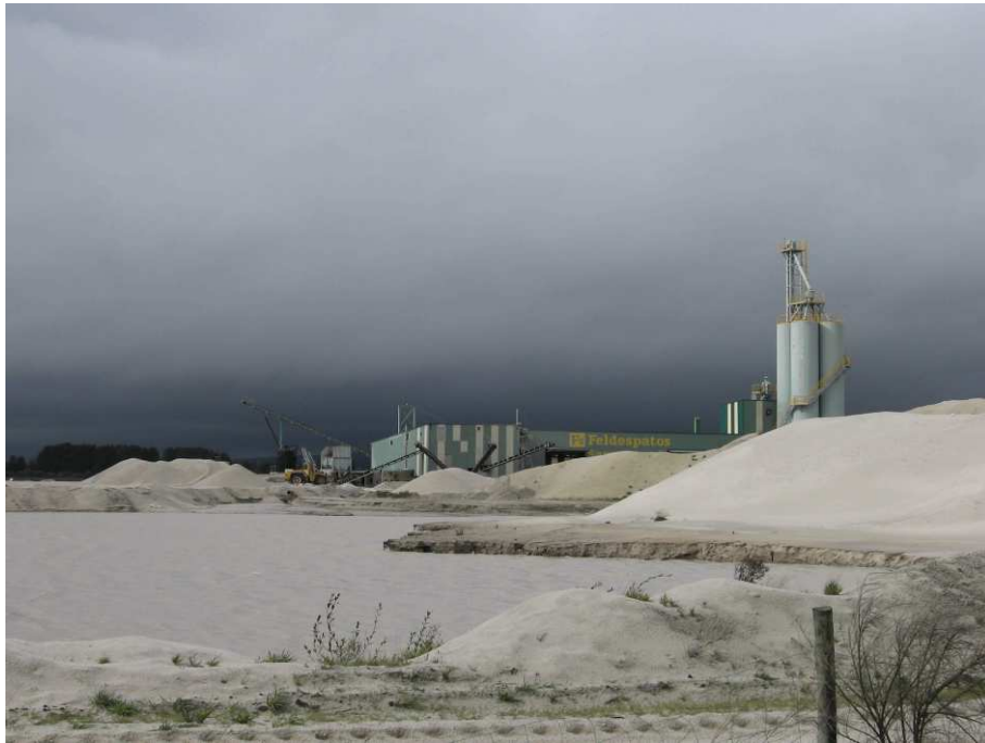
Figura 28.- Vista general de la explotación y de la planta.
