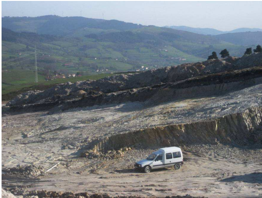
Figura 11.- Aspecto del desmonte de preparación de la capa.
